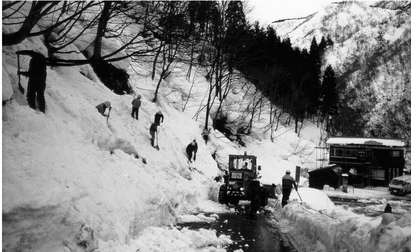
山斜面の雪庇落とし(前倉橋付近)
